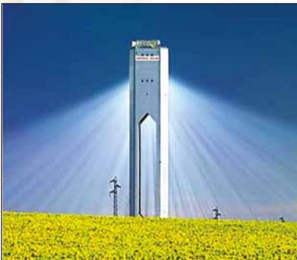
Гелиотермальная солнечная электростанция башенного типа в Испании, тысячи зеркал направляют концентрированный солнечный свет на бетонную башню с теплоносителем.
